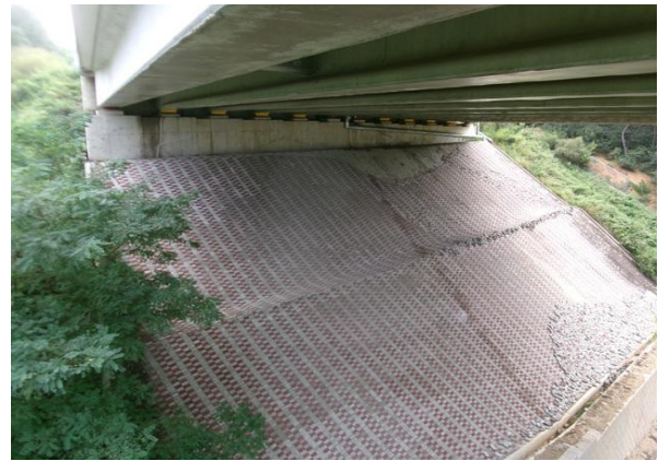
교대 A2 기초 전경
