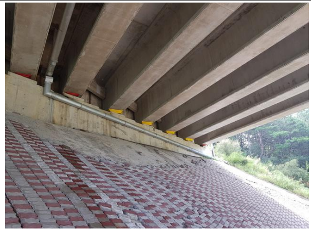
교대 A2 기초 전경
