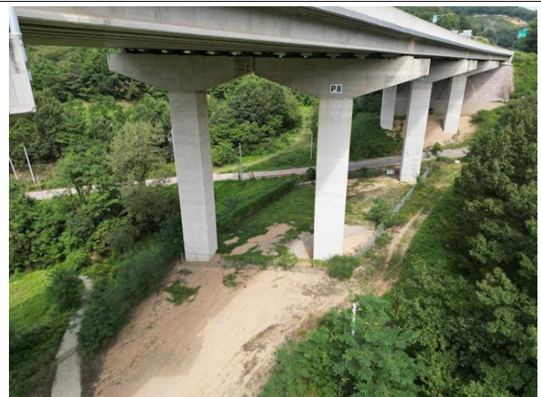
교각 P8~10 기초 전경
