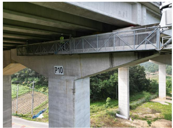
굴절점검차를 이용한 근접조사
