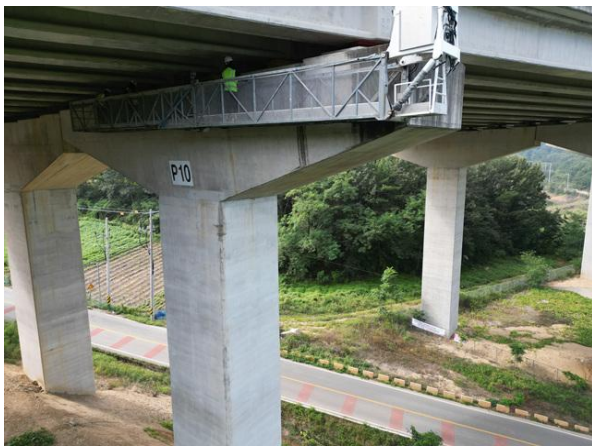
굴절점검차를 이용한 근접조사
