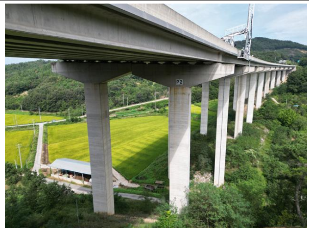
교각 P2~3 기초 전경
