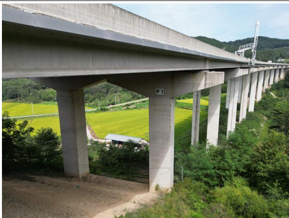
교각 P1 기초 전경
