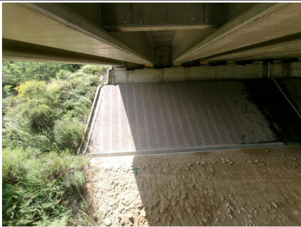
교대 A1 기초 전경
