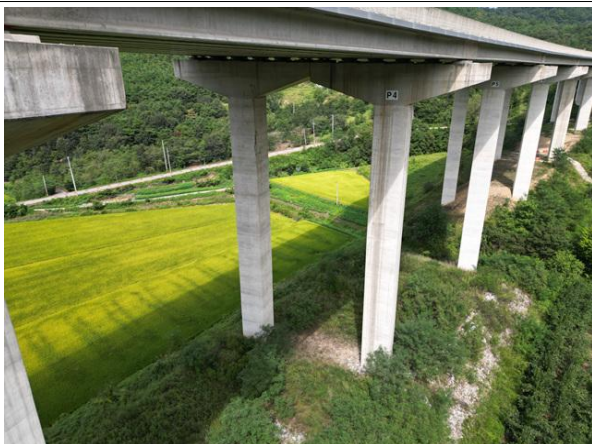
교각 P4~5 기초 전경
